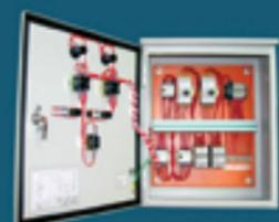
El equipo eyector consta de un tablero eléctrico de control, dos o más motobombas sumergibles y dos interruptores de flotador. Opcional alarma de control de nivel del pozo, compuesta por una alarma sonora y un interruptor de flotador.
